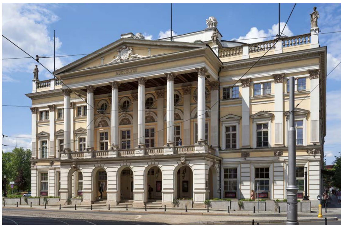
Opera będzie wystawiała jeszcze tylko dwa miesiące, potem zaczną się prace modernizacyjne
