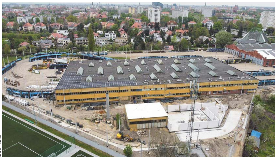
Rozbudowa zajezdni tramwajowej Borek przy ul. Powstańców Śląskich trwa od października 2022 roku
